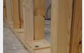
getrennter Ständer - durchgängige Schwelle und Rähm
